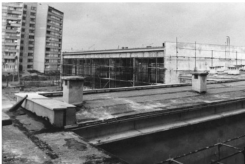
Budowa hali basenowej przy Szkole Podstawowej nr 3 w Polkowicach na przełomie lat 82/83
