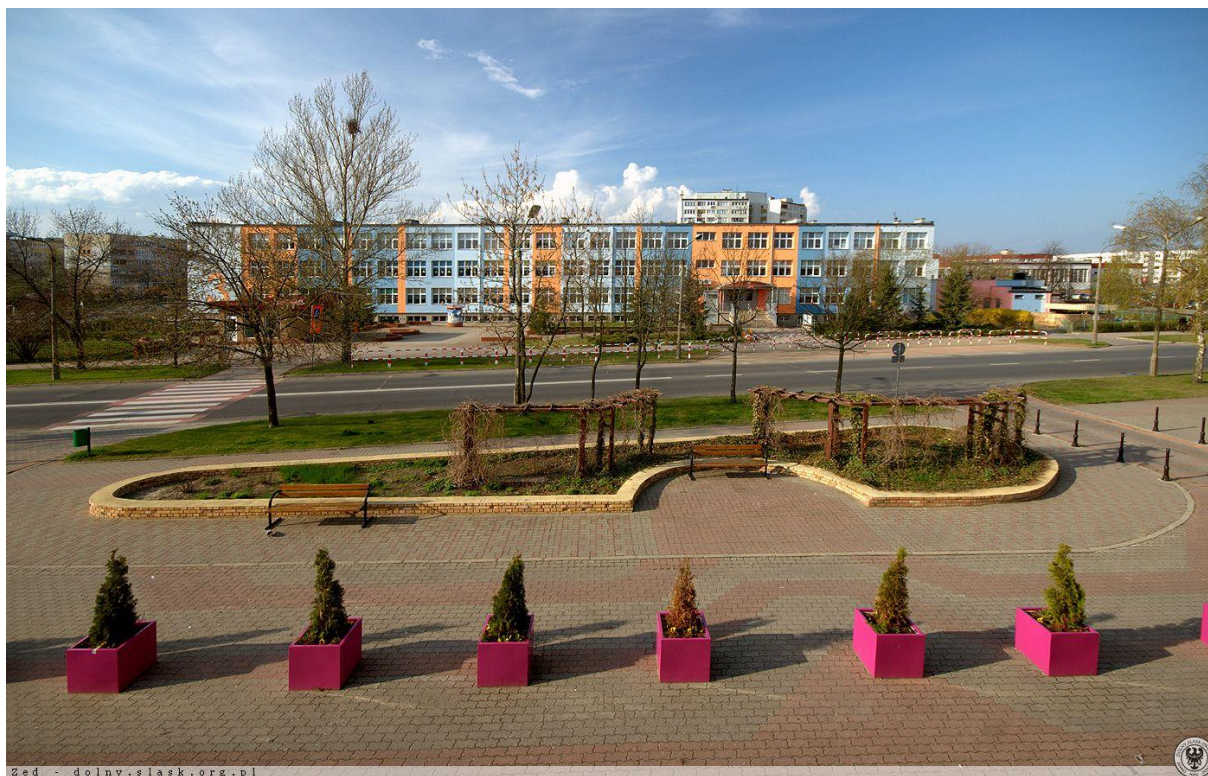
Po remoncie elewacji/ 2007 r.
