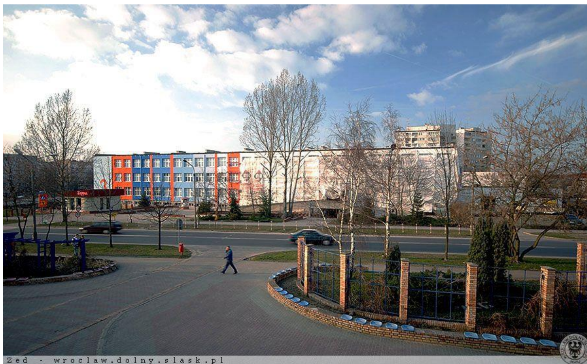
Remont elewacji szkoły nr 3 / 2007 r.
